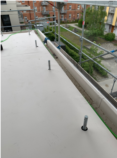
Referenzbeispiel Befestigung Geländer
